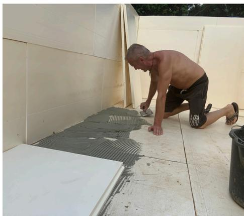
**Zweite Lage Styrodur:** Verlebe eine zweite Schicht Styrodur auf dem Boden, um zusätzlichen Schutz und Isolation zu bieten.
