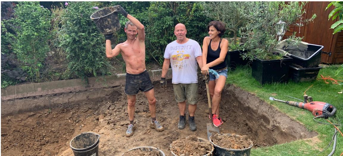
Der Transport der Erde: Jede Schaufelladung Erde wurde in Eimern auf einen Leiterwagen gepackt, durch die Garage gefahren und in die bereitgestellten Big Packs entladen. Diese Big Packs fassen jeweils etwa 1 Kubikmeter Erde, was ungefähr 1 Tonne entspricht. Insgesamt haben wir so 50 Tonnen Erde bewegt – eine unglaubliche Leistung, die ohne den Einsatz von Freunden und Familie kaum machbar gewesen wäre.
